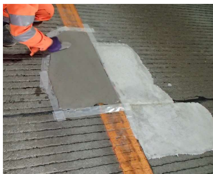
ポットホール補修
