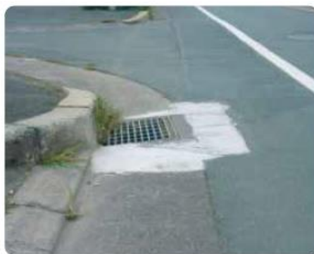
■ 集水枡復旧補修
