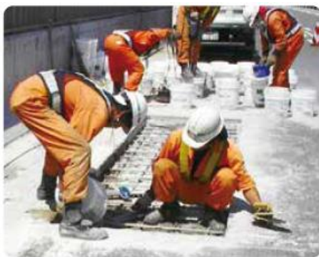
■ 中央自動車道松本管内維持修繕
