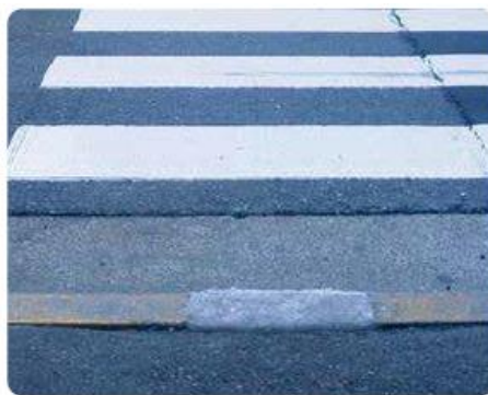
■ 歩車道ブロック補修
