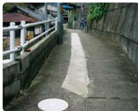
■ 歩道部段差補修
