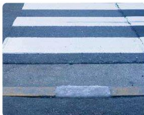
■ 歩車道ブロック補修
