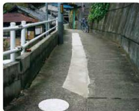
■ 歩道部段差補修
