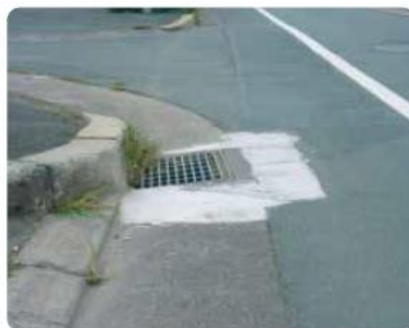
■ 集水樹復旧補修
