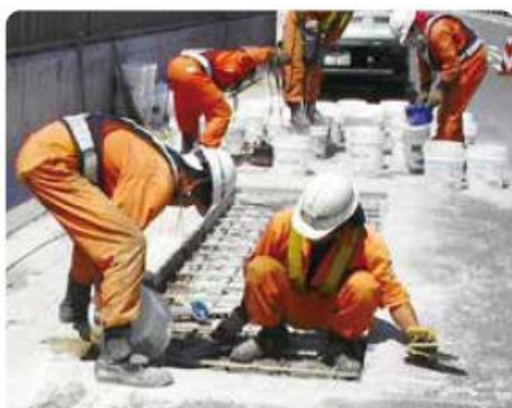
■ 中央自動車道松本管内維持修繕
