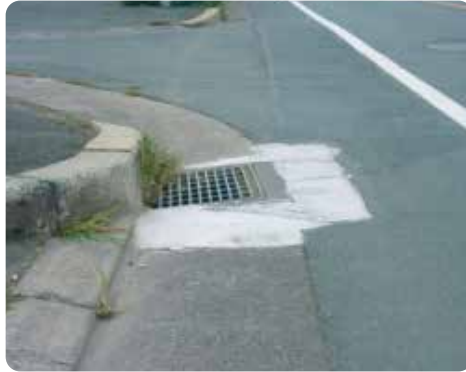
■ 集水樹復旧補修
