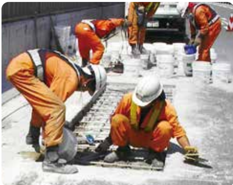
■ 中央自動車道松本管内維持修繕
