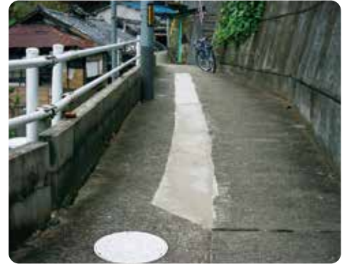
■ 歩道部段差補修
