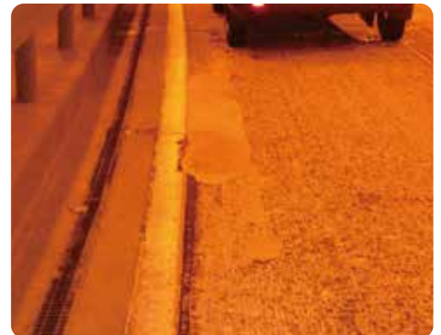
■ 賤母(しずも)トンネル内コンクリート舗装補修
