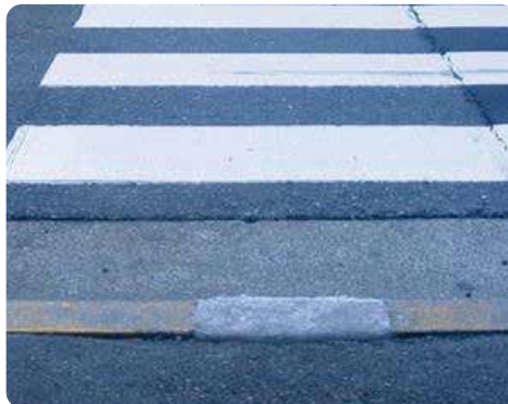
■ 歩車道ブロック補修
